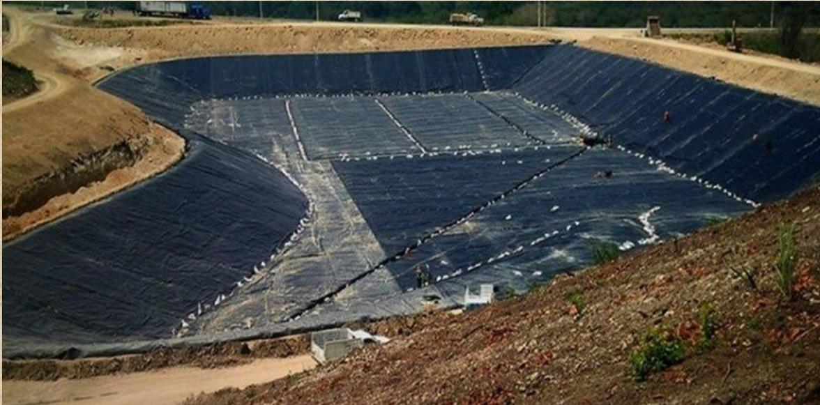
*Nota.* La imagen muestra la infraestructura e instalación de un relleno sanitario para depositar los residuos sólidos. Tomado de *La Ingeniería de los Rellenos Sanitarios* [Fotografía] por Coprocesamiento, 2020 ([www.coprocesamiento.org](http://www.coprocesamiento.org)).
