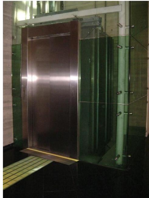
**Ilustración N°22: Ascensor, con adaptaciones de Banda o Pavimento Táctil y de color.**
