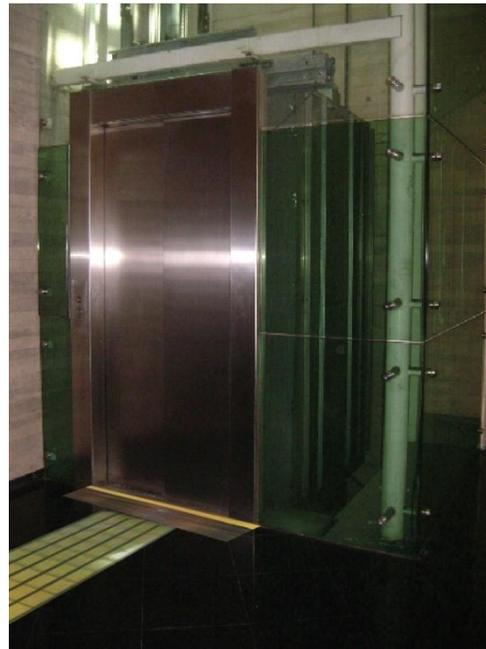
**Ilustración N°6: Ascensor del Nivel del Metro, con adaptación de Banda o Pavimento Táctil y de color.**
