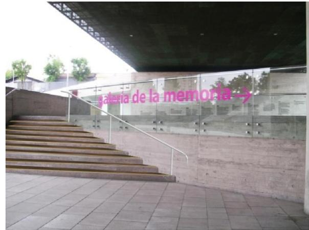
**Ilustración N°9: Escalera exterior, con adaptación de pasamanos a ambos lados y Banda o Pavimento Táctil y de color.**
